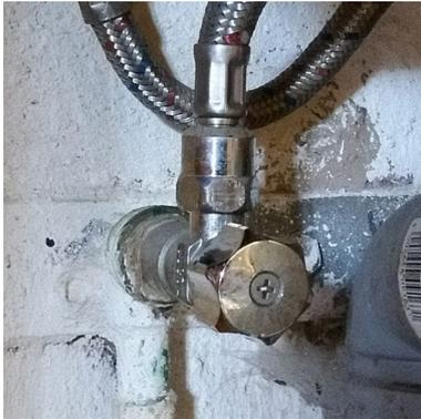
Der Leitungswasseranschluß erfolgt am Eckventil unter der Spüle, genau da, wo schon der Kaltwasserhahn der Spüle angeschlossen ist. Dieser ist in der Regel über einen Panzerschlauch mit dem Eckventil verbunden. Zuerst wird das Eckventil geschlossen und testweise der Kaltwasserhahn kurz geöffnet, um zu prüfen, ob es auch wirklich das Eckventil fürs kalte und nicht das fürs warme Wasser ist. Dann wird der Panzerschlauch vom Eckventil abgeschraubt.
