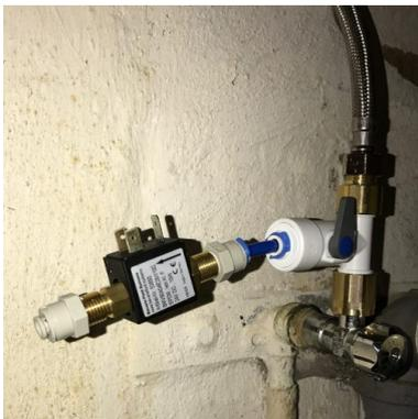
Auf das Eckventil kommt jetzt das T-Stück, welches mit einem kurzem Schlauch mit dem Magnetventil verbunden ist. Die untere Messingmutter vom T-Stück ist beweglich und wird auf das Eckventil geschraubt. In dieser Mutter muss ein Dichtring sitzen. Oben auf das T-Stück wird der Panzerschlauch vom Kaltwasserhahn angeschraubt, auch der hat eine Dichtung. Da auch die obere Messingverbindung beweglich ist, muss sie mit einem passenden Schraubenschlüssel beim Schrauben gegengehalten werden.
